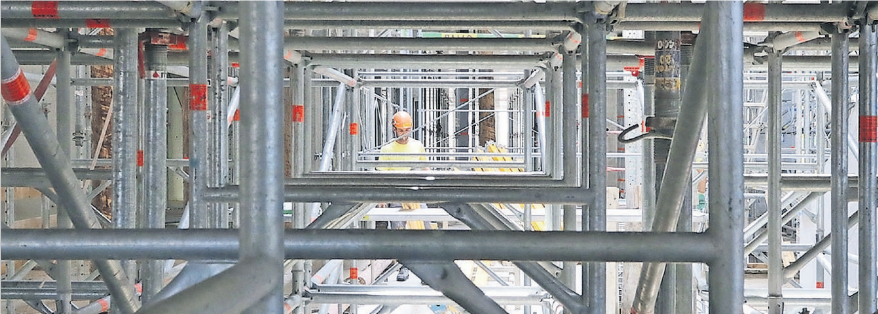
Arbeit hinter Gittern: Im Rohbau des künftigen PJZ sind auch solch beeindruckende Stangendschungel anzutreffen. Fotos: Lisa Maire
