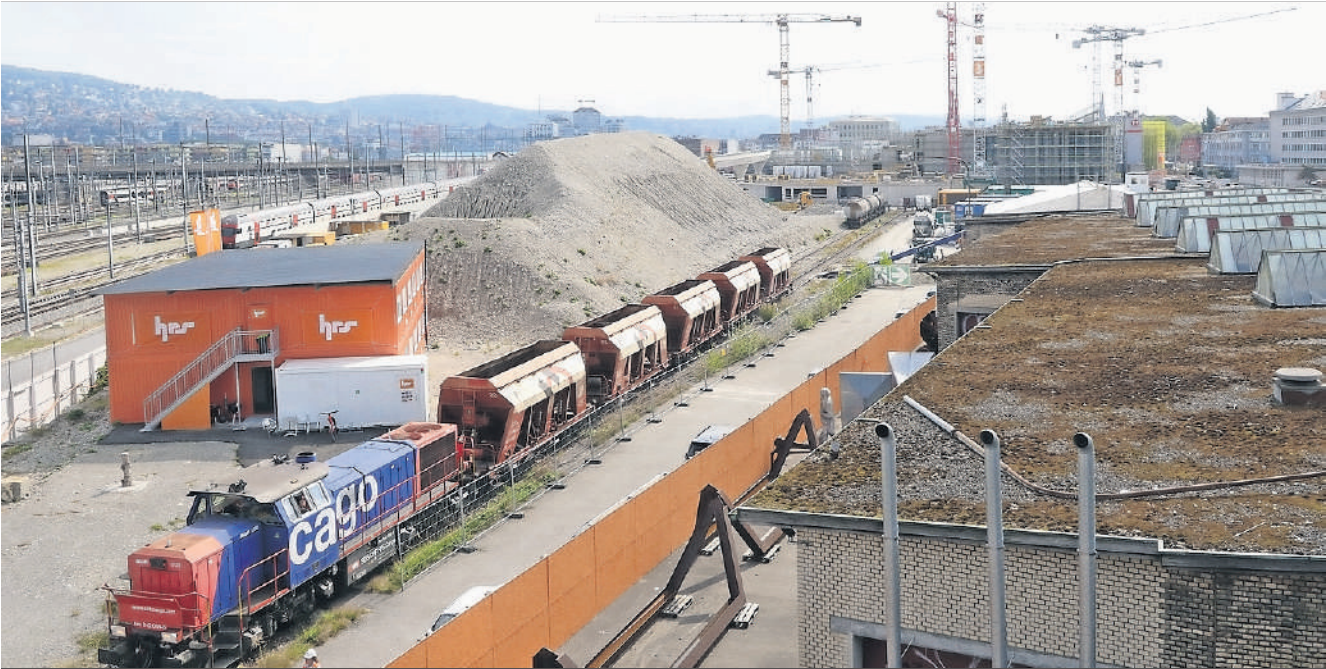
Baustoffe wie Kies und Sand oder grosse Fassadenteile gelangen per Bahn auf das riesige Baugelände. Der Berg mit Aushubmaterial, das für Gebäude-Hinterfüllungen und Terrainanpassungen verwendet wird, schrumpft laufend. Rechts im Bild das letzte Überbleibsel des alten Güterbahnhofs.
