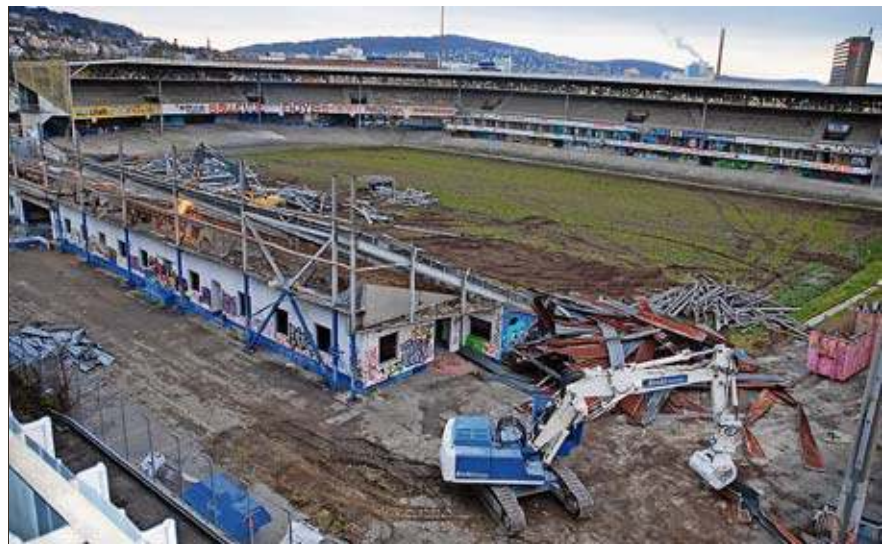
Der alte Hardturm wurde 2008 abgerissen, rückblickend etwas voreilig. Trotz der Niederlage am Sonntag sind Pläne vorhanden, hier einen neuen Fussballtempel zu bauen. Archivfoto: ls.
